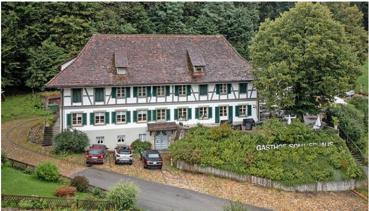
Im Gasthof Sommerhaus wird gebaut. Von aussen wird er danach immer noch gleich aussehen. Foto: Beat Mathys
